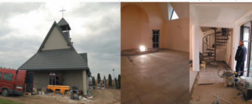
Prace wykończeniowe w Kaplicy w Kaszycach
